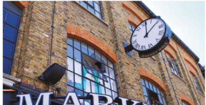
Mocowanie elementów instalacji budowlanych
