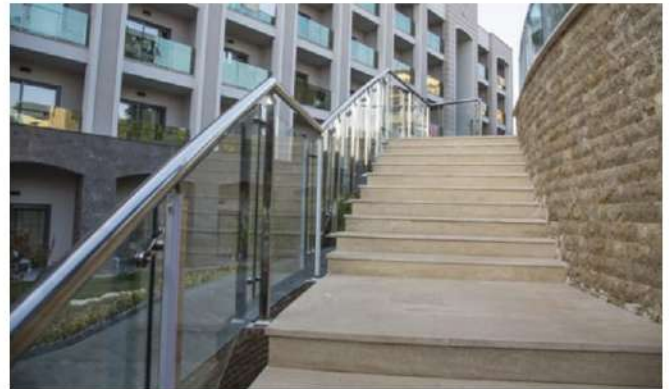
Mocowanie elementów instalacji budowlanych
