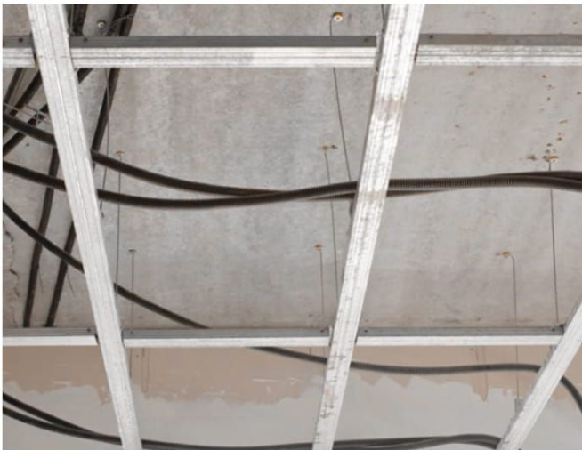
Montaż profili przyściennych w sufitach kasetonowych
