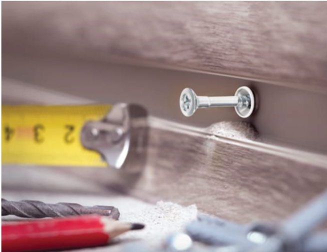
Montaż listew przypodłogowych
