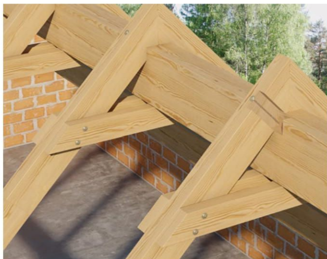
Montaż więźby dachowej
