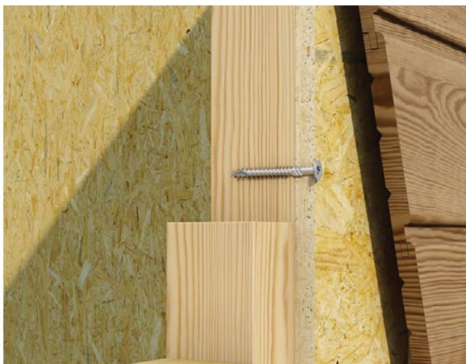
Montaż płyt do konstrukcji drewnianej
