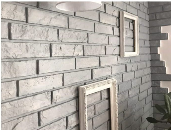
Montaż elementów aranżacji w podłozach z okładzin gipsowych
