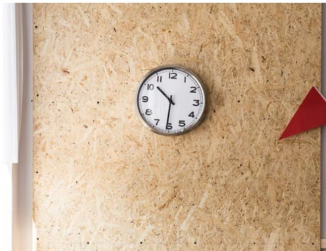
Montaż elementów ozdobnych w podłozach z płyt OSB
