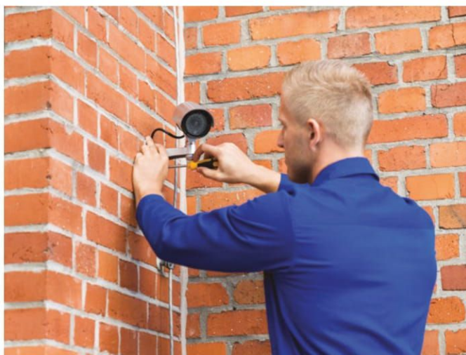
Montaż elementów monitoringu na ścianach z cegieł
