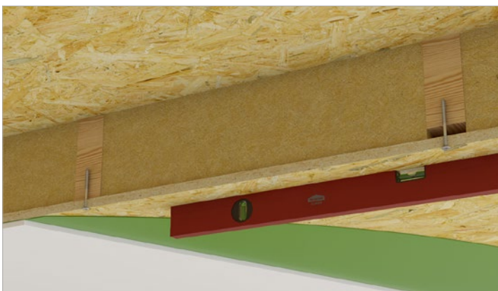
Poziomowanie powierzchni sufitów
